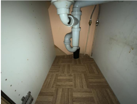
Besiktigelse av røropplegg.
