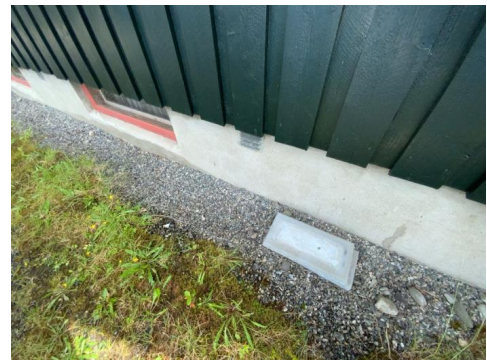
Kontroll av drenering/fuksikring.
