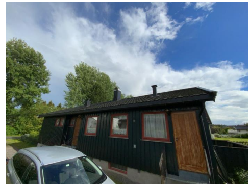
Besiktigelse av taktekke.
