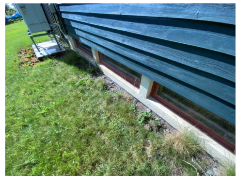
Kontroll av drenering/fuksikring.
