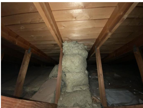
Kontroll rundt rørgjennomføringer.
