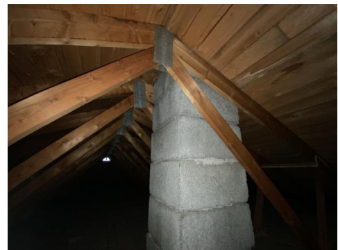
Kontroll rundt pipeløp.
