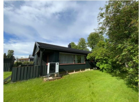
Besiktigelse av taktekke.
