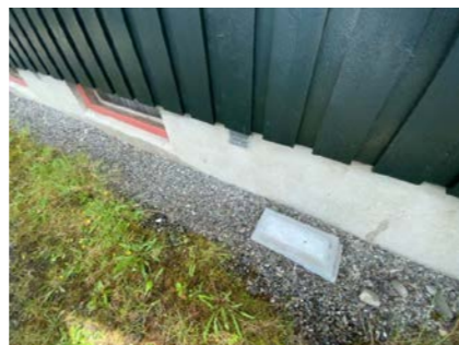
Kontroll av drenering/fuktsikring.
