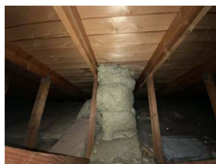
Kontroll rundt rørgjennomføringer.
