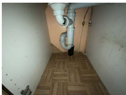
Besiktigelse av røropplegg.
