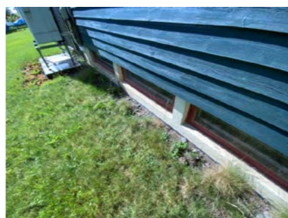
Kontroll av drenering/fuktsikring.
