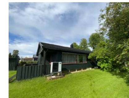
Besiktigelse av taktekke.
