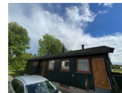
Besiktigelse av taktekke.
