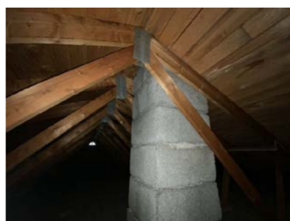
Kontroll rundt pipeløp.
