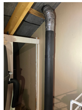
Rør vurdert til å være avløpslufting over tak.
