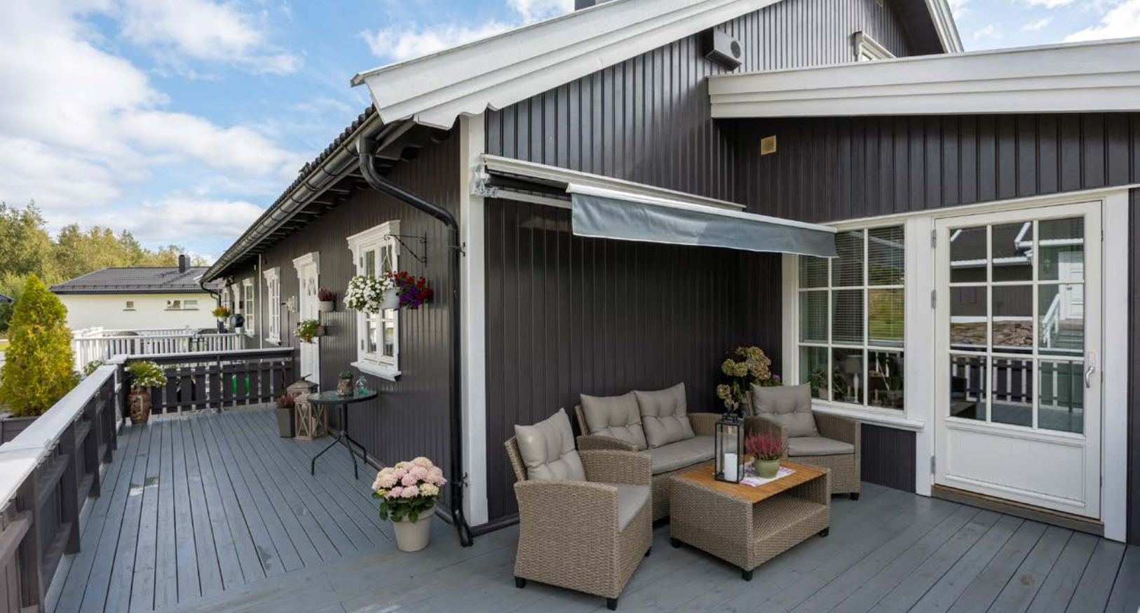
Ved inngangspartiet er det en herlig, vinklet terrasse på ca. 27 kvm. Her er det også dekke og rekkverk i tre, markise og utebelysning.
