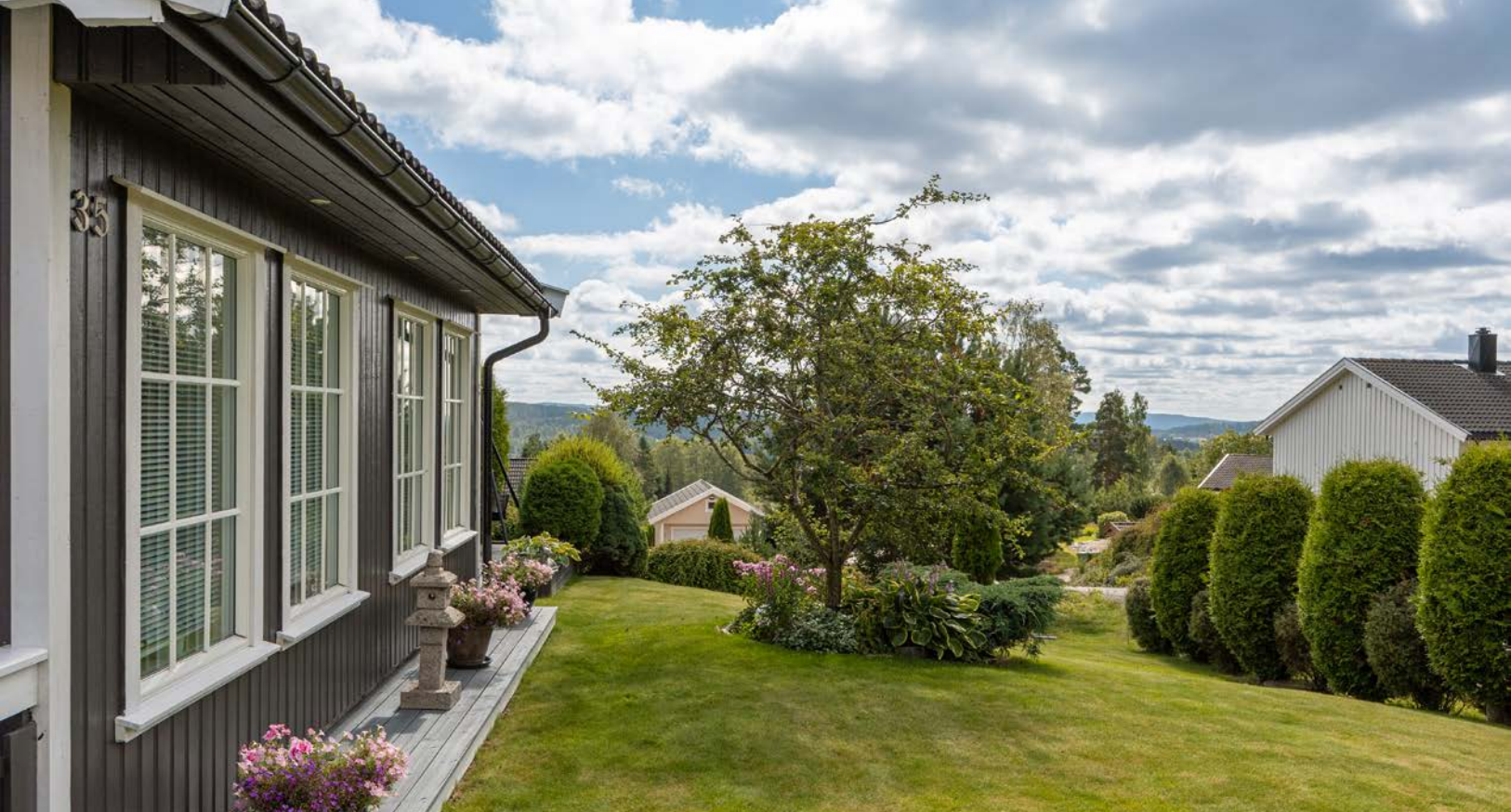
Huset fremstår som meget godt vedlikeholdt – både utvendig og innvendig.
