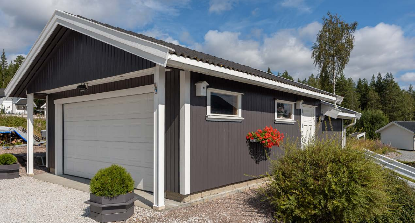
Garasjen har elbillader, motorisert port og 2 lagringsboder.
