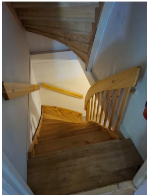
Trapp mellom kjelleretasje og første etasje.
