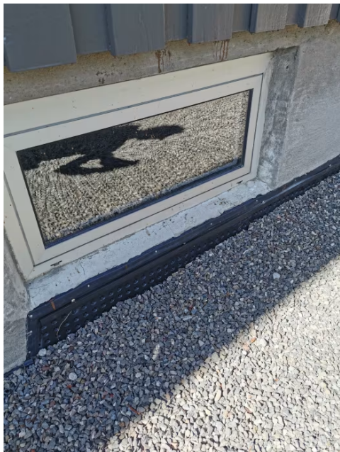
Synlig grunnmursplast med klemlist.
