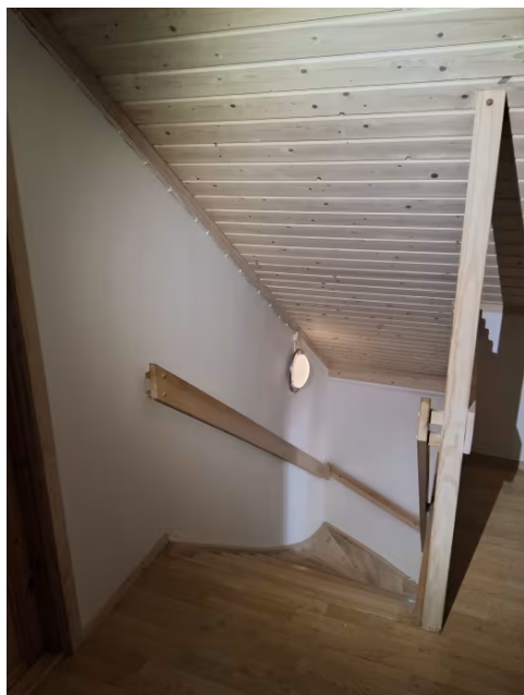
Trapp mellom første etasje og loftsetasje.
