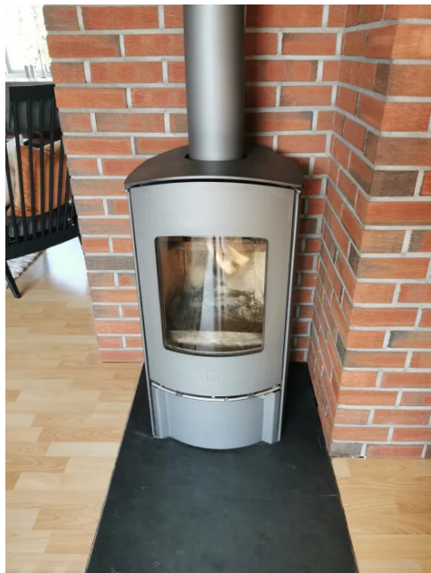
Vedovn med glassdør i stue.
