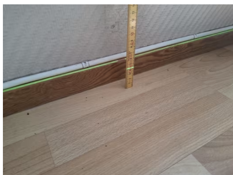
Etasjeskiller er kontrollert med nivelleringslaser.
