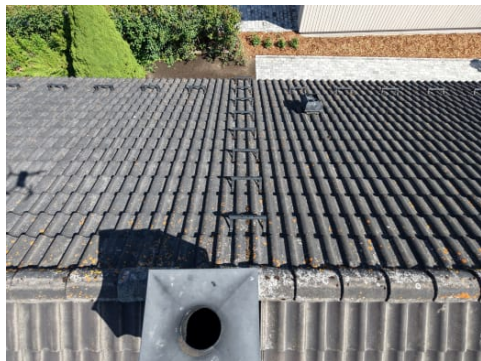
Det er etablert takstige til pipe.
