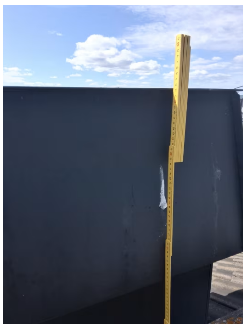
Pipehøyde er målt til under 80cm over tak.
