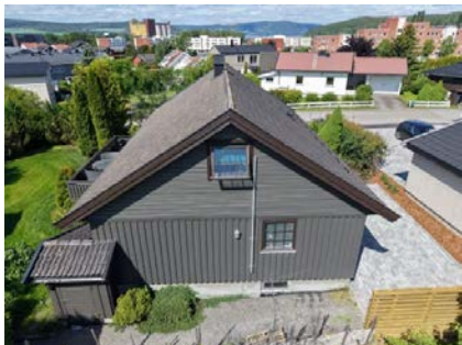
Boligen er oppført med saltak.
