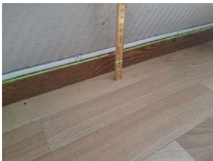
Etasjeskiller er kontrollert med nivelleringslaser.
