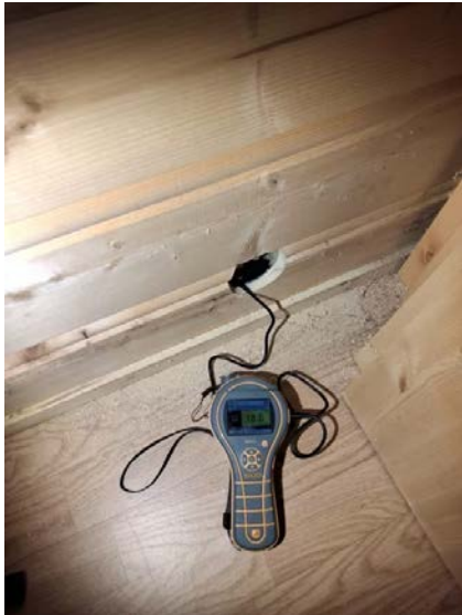
Bilde fra fuktmåling i utlektet kjellervegg.
