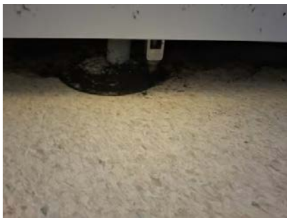
Dusjkabinett er plassert på slukrist.
