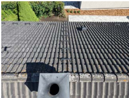
Det er etablert takstige til pipe.
