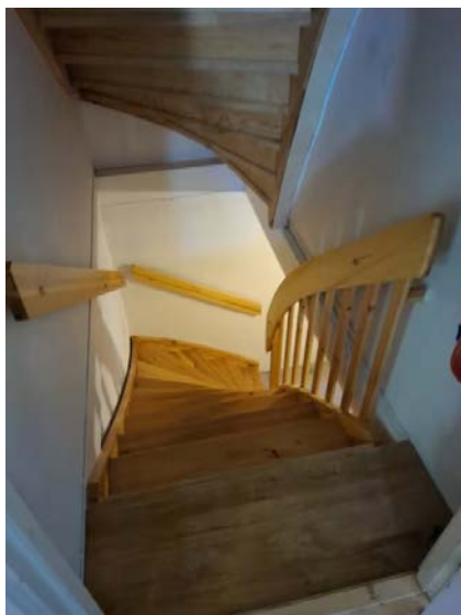
Trapp mellom kjelleretasje og første etasje.
