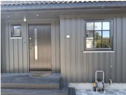
Boligen har entrédør glassfelt og vinduer med to-lags glass.
