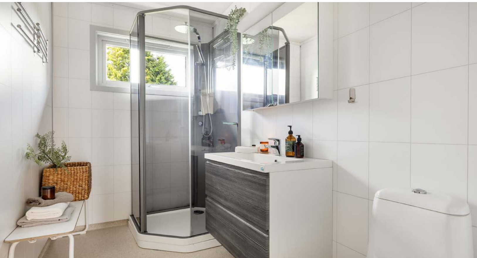
Bad med belegg på gulvet og våtromsplater på veggene. Det er installert dusjkabinett.
