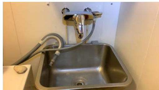
Det er uegnede materialer i den definerte våtsonen bak vaskekum.
