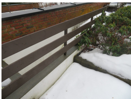
Rekkverk mot trapp ved terrasse.
