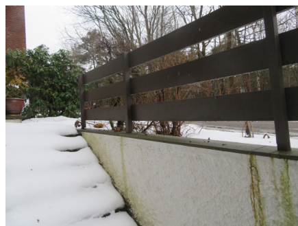
Rekkverk på trapp på inngangssiden.
