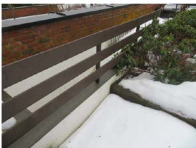
Rekkverk mot trapp ved terrasse.
