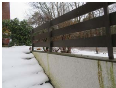
Rekkverk på trapp på inngangssiden.
