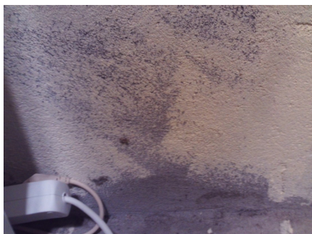
Synlig grunnmur i ene boden.
