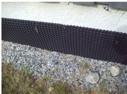
Nyere fuktsikring inntil grunnmur.
