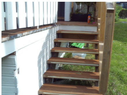
Ny utvendig trapp til terrasse.
