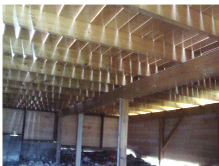
Under terrasse med fundamentering
