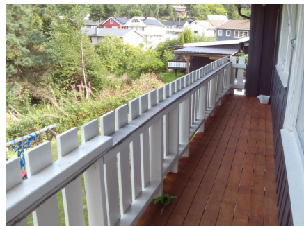
Dekke og rekkverk byttet på veranda
