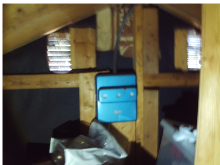
Hovedinntaket på kaldtloftet
