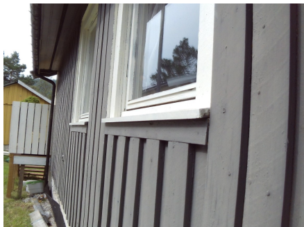
Deler av kledningen med tilhørende takrenner.
