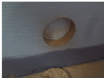
Hulltaking i utfored vegg på vaskerommet
