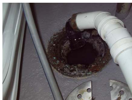
Eldre opprinnelig sluk
