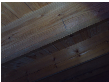
Deler av takkonstruksjonen.
