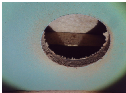
Hulltaking fra soverommet
