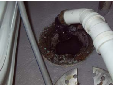
Eldre opprinnelig sluk
