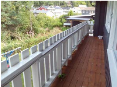
Dekke og rekkverk byttet på veranda
