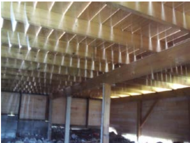
Under terrasse med fundamentering
