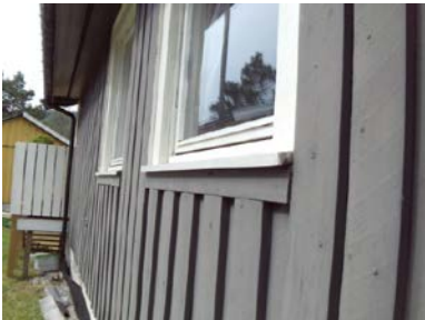
Deler av kledningen med tilhørende takrenner.
