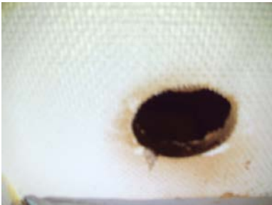
Hulltaking i vegg mot bad
