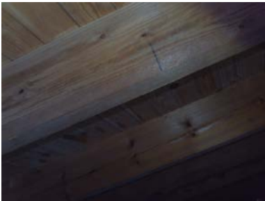
Deler av takkonstruksjonen.
