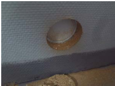
Hulltaking i utfored vegg på vaskerommet
