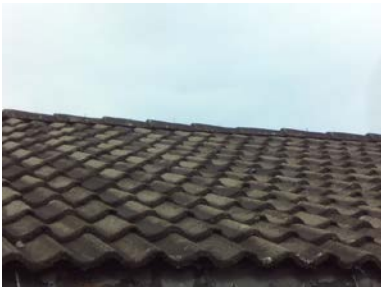
Deler av taktekkinge
