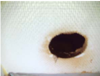
Hulltaking fra vaskerommet
