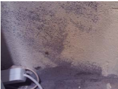
Synlig grunnmur i ene boden.
