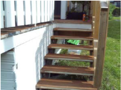
Ny utvendig trapp til terrasse.
