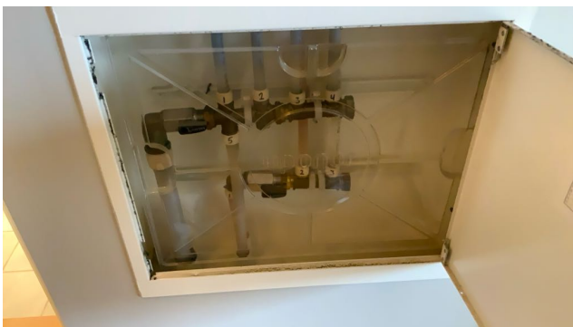
Besiktigelse av røropplegg.
