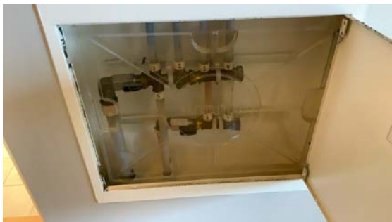
Besiktigelse av røropplegg.
