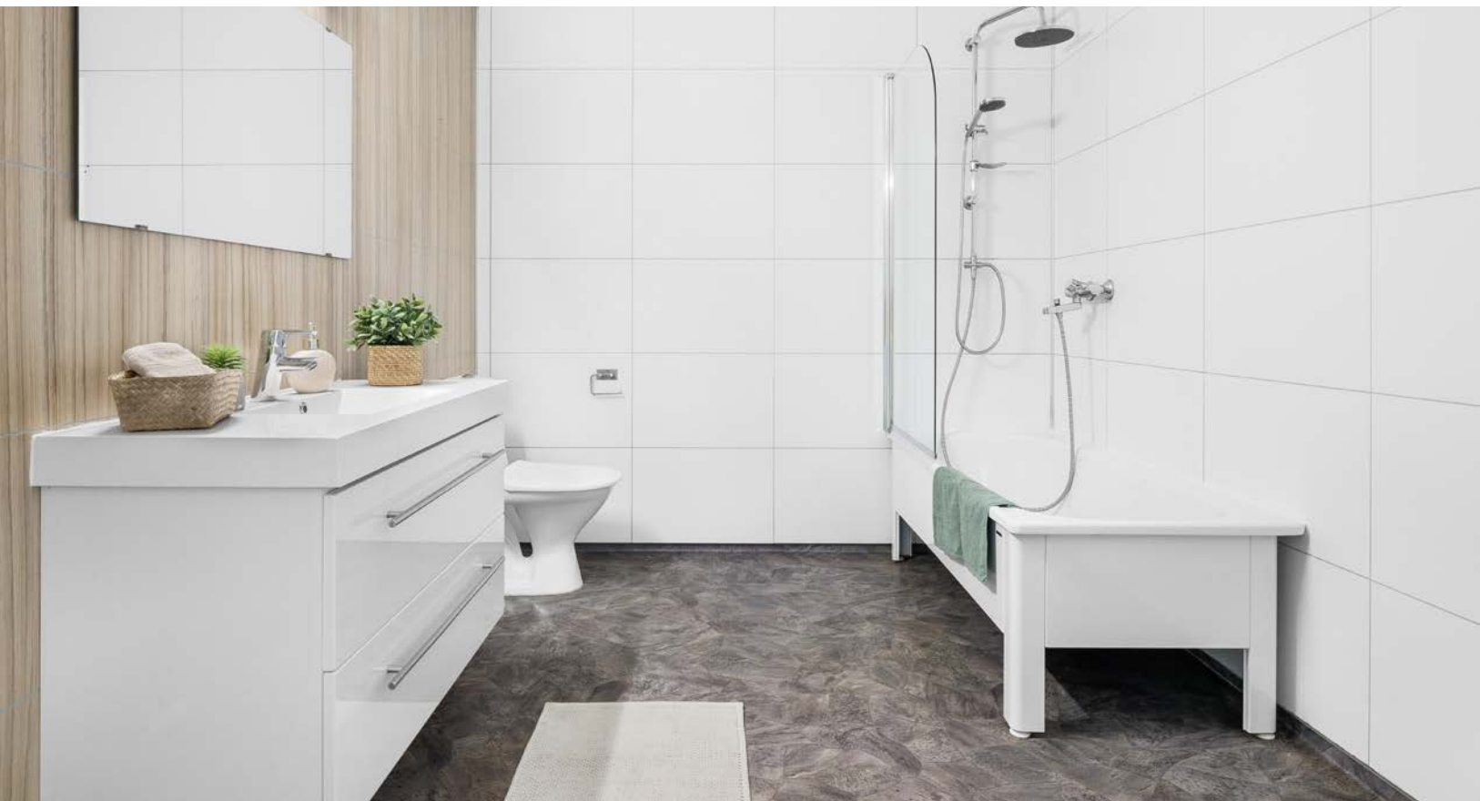
Baderommet har belegg på gulvet og vegger med våtromsplater. Badekar med dusjløsning.
