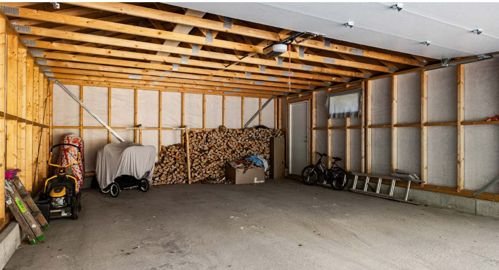
Dobbeltgarasje på 44m 2 . Montert leddport med motorstyring og strøm.
