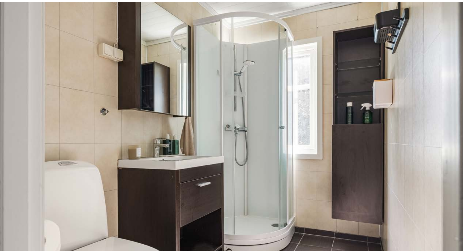
Pent baderom oppgradert i 2014 med nye overflater, innredninger og sanitærutstyr. Badet har mørke fliser på gulv (lagt oppå eksisterende eldre våtromsbelegg), våtromsplater på veggene og elektrisk styrt vifte.
