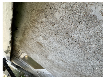
Tettet igjen for lufting.
