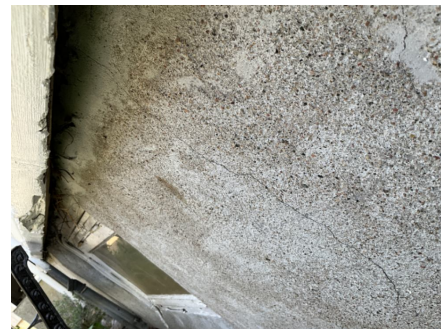
Tettet igjen for lufting.
