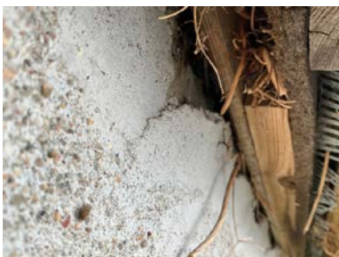
Åpninger inn bak vindtettingen.
