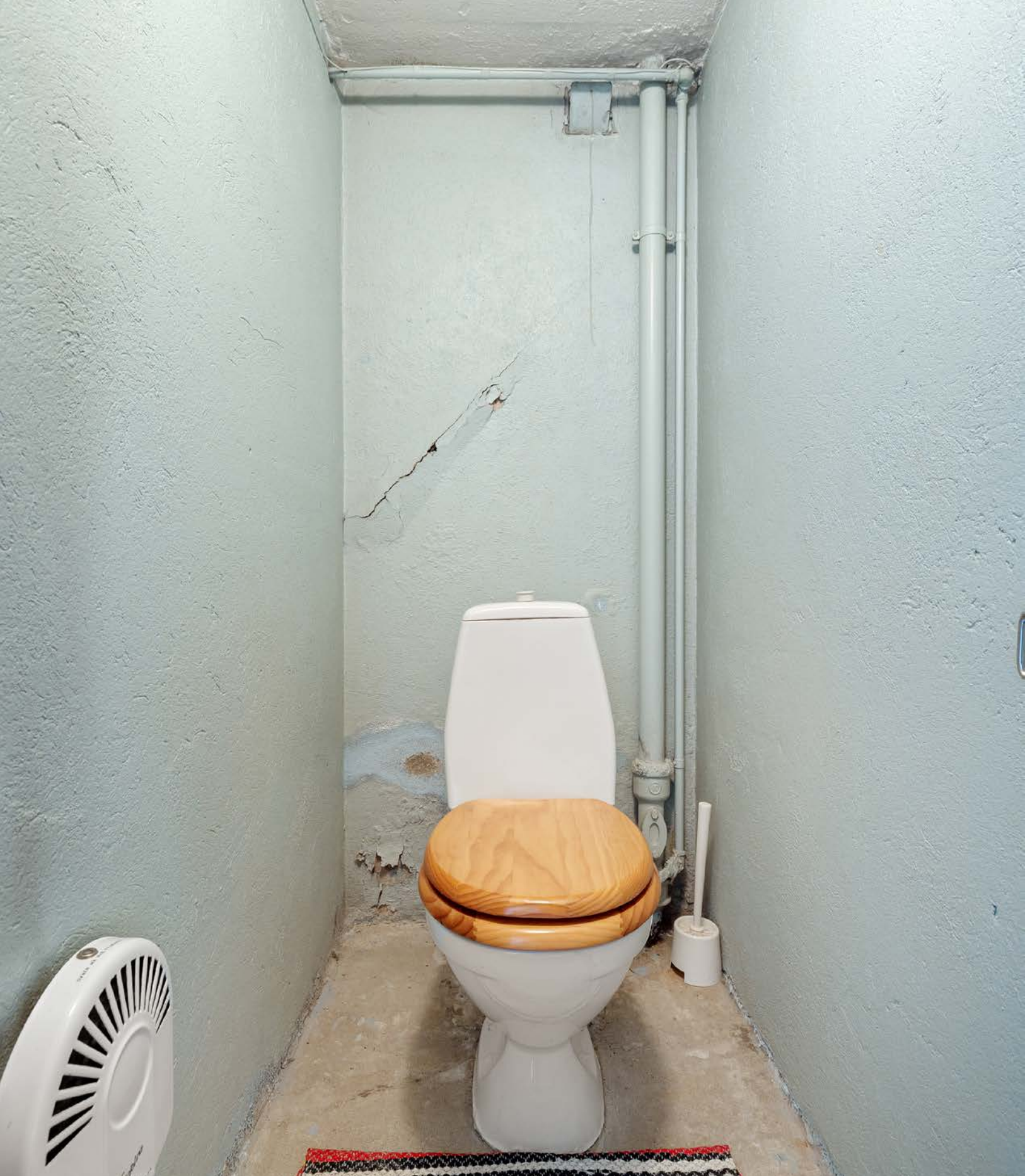
Toalettrom i kjelleren.
