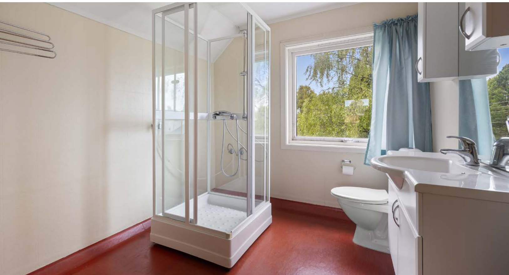
Bad med vinylbelegg på gulv og våtromstapet på vegger. Badet er innredet med servant i baderomsinnredning, toalett og dusjkabinett.
