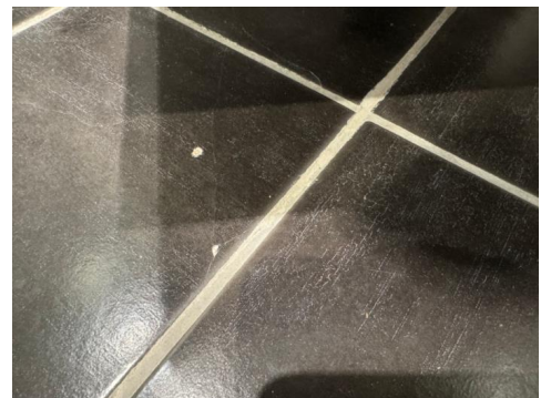
Sprekker i gulvfliser. Pga. fallforhold mot sluk monterte tidligere eier stå list på gulv v/ dusjsone.
