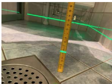
Godt fall fra topp flis ved dør til topp flis ved sluk
