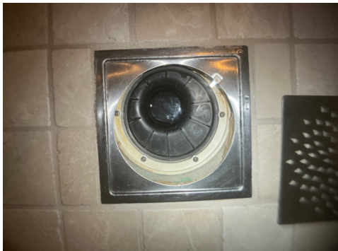
2.ETASJE > BAD - 6M2
