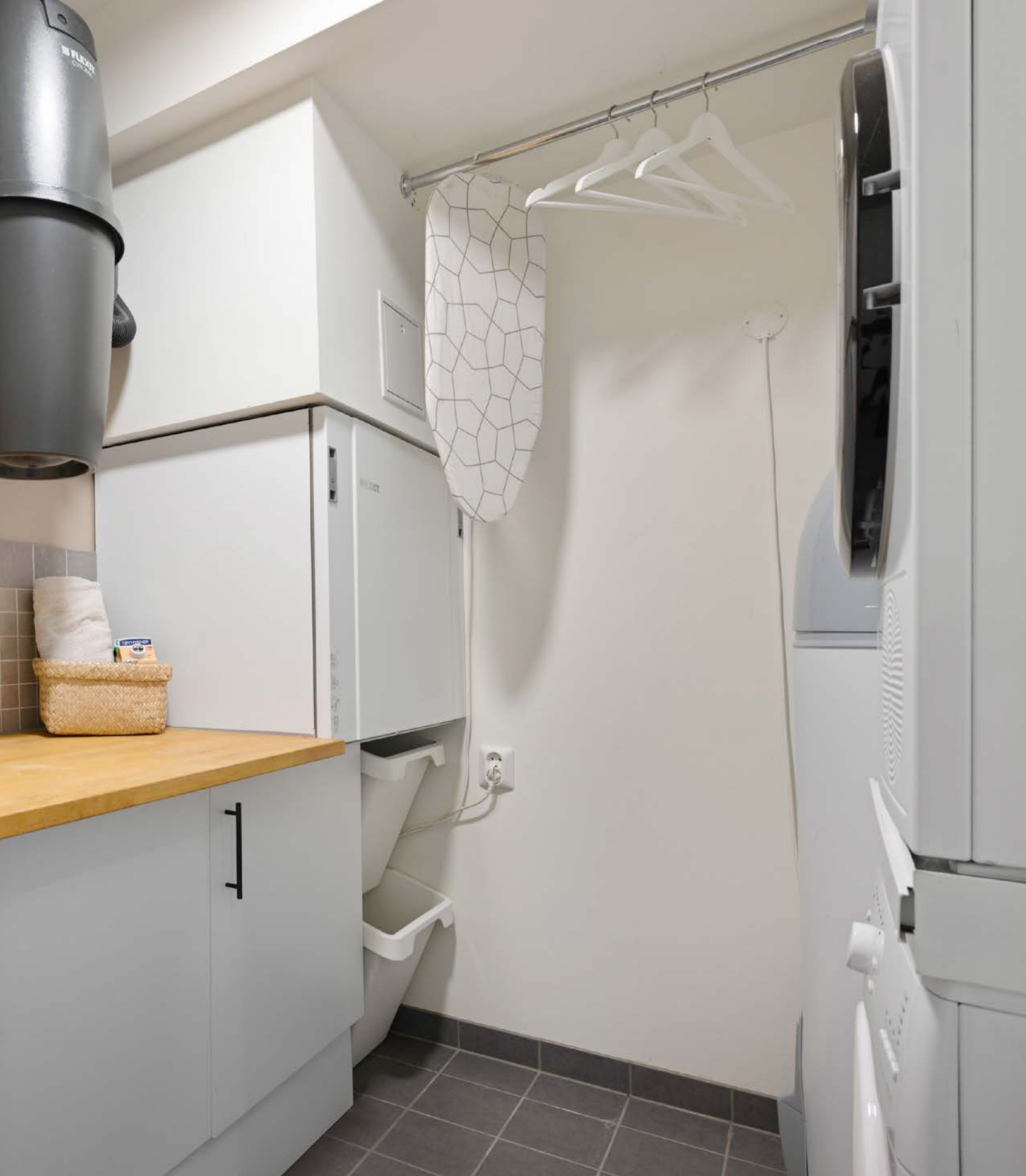
Teknisk rom med opplegg for vaskemaskin.
