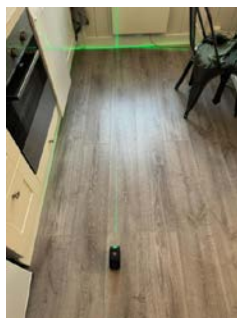
Foto viser nivellering med krysslaser på kjøkken
