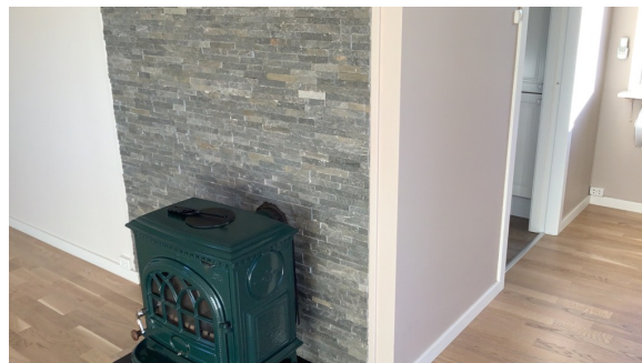
En pipevange er innkledd bak delevegg.
