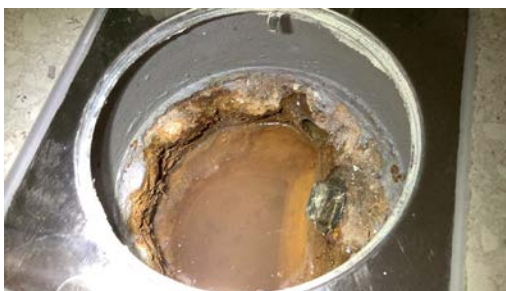
Støpejernsluk, og smøremembran er smurt ned i sluket.
