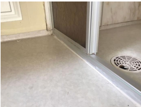
Ikke tilgang til sluk fra hele gulvet.
