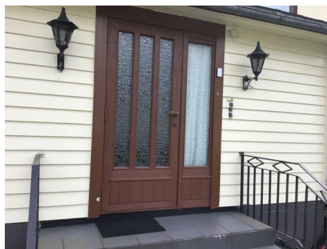
Inngangsdør til fellesgang i 1 etg
