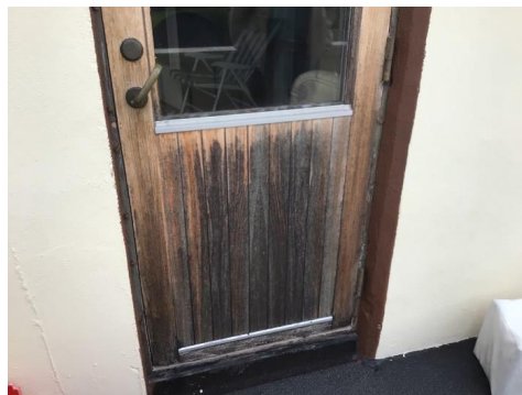
Balkongdør i stue
