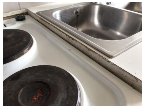
Skader på benkeplate
