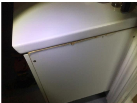
Skader på baderomsinnredning
