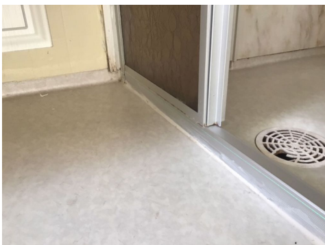
Ikke tilgang til sluk fra hele gulvet.
