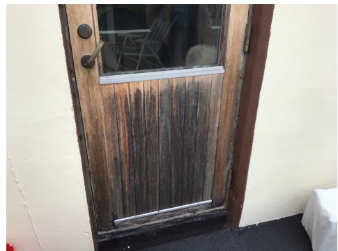
Balkongdør i stue
