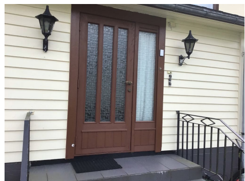
Inngangsdør til fellesgang i 1 etg
