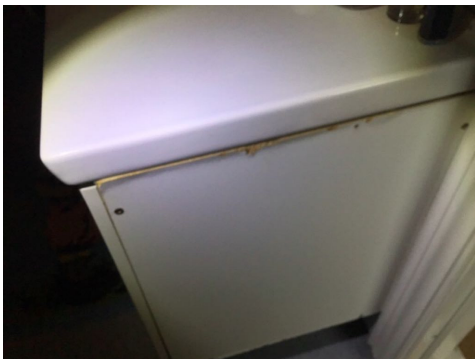
Skader på baderomsinnredning
