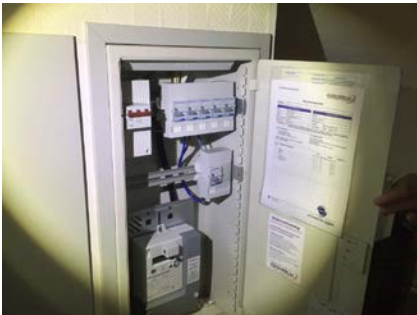
Plassert i gang loft
