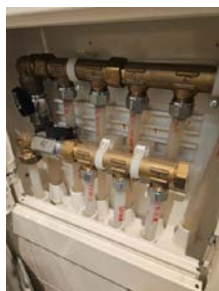
Fordelerskap for rør i rør system.
