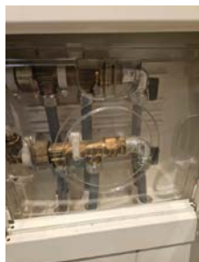
Fordelerskap for vannboren varme.
