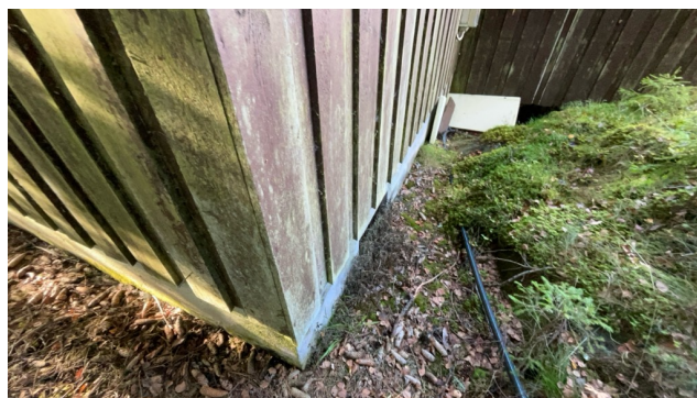
Kontroll av drenering/fuktsikring.
