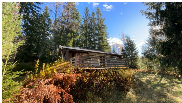
Besiktigelse av taktekke.
