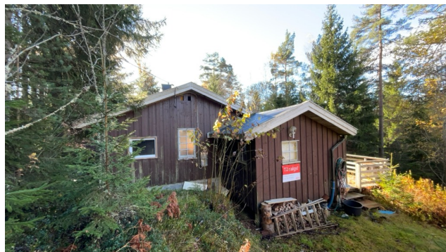
Besiktigelse av taktekke.
