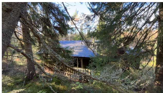
Besiktigelse av taktekke.
