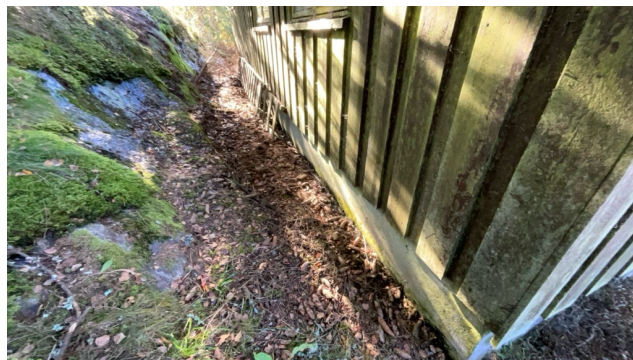
Kontroll av drenering/fuktsikring.
