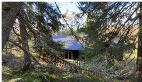
Besiktigelse av taktekke.
