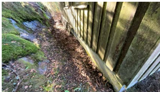
Kontroll av drenering/fuktsikring.
