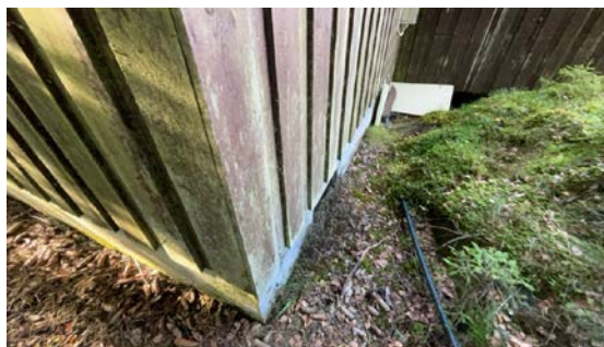
Kontroll av drenering/fuktsikring.
