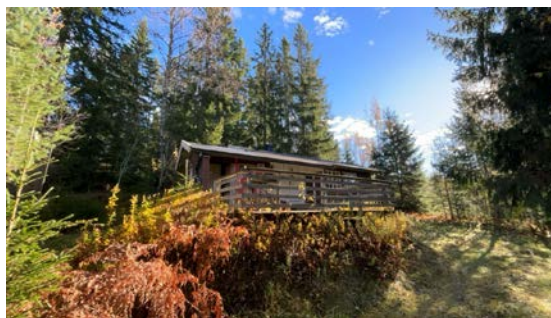
Besiktigelse av taktekke.
