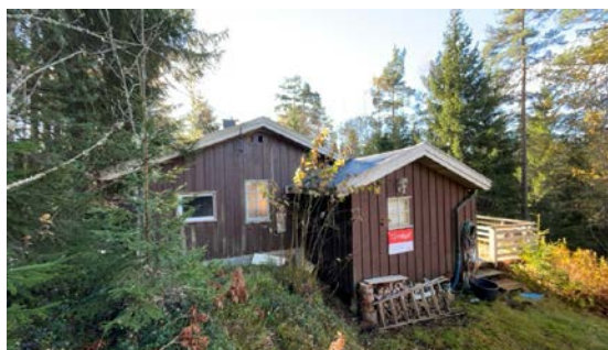
Besiktigelse av taktekke.
