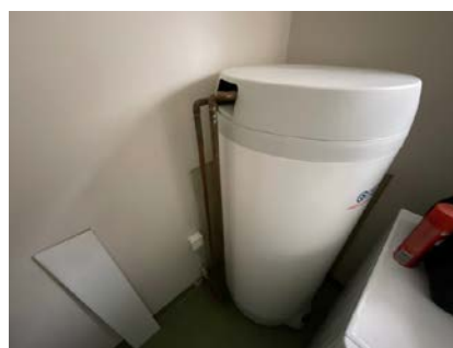
Varmtvannsbereder
