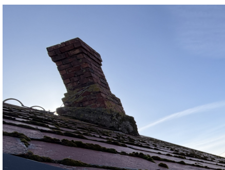
Pipe over tak uten beslag
