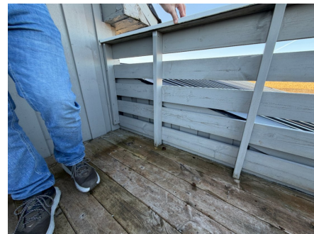
Overgang balkong og tilbygg.
