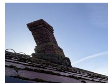
Pipe over tak uten beslag
