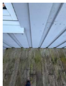
Gulvbord helt inn mot bordkledning
