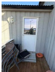
Gulvbord helt inn mot bordkledning
