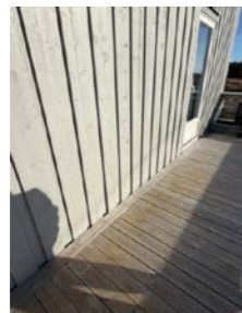
Gulvbord helt inn mot bordkledning
