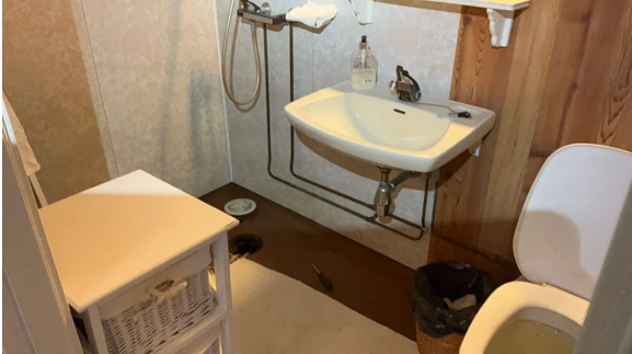
Oversiktsbilde av bad.
