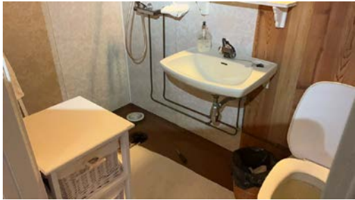
Oversiktsbilde av bad.
