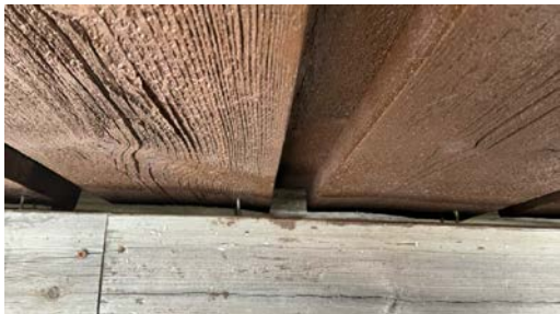
Glippe mellom veranda og yttervegg. Sannsynligvis grunnet bevegelser i konstruksjonene.
