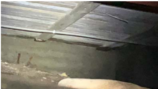
Synlig fukt i etasjeskiller på nordsiden i krypkjeller.
