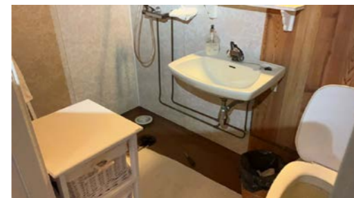
Oversiktsbilde av bad.
