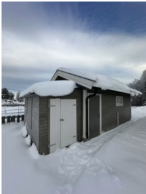
Viser inntilbygget bod i bakkant av garasje.
