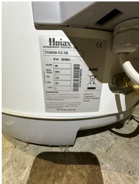
Viser teknisk data på bereder
