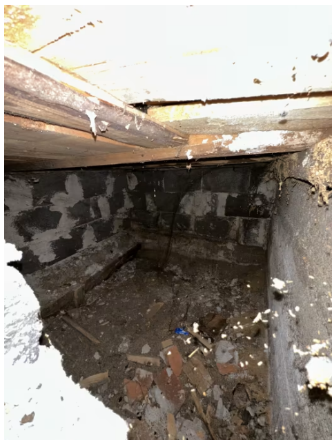
Viser rom i kjeller uten etablert adkomst. Bilde tatt fra luke i vegg.
