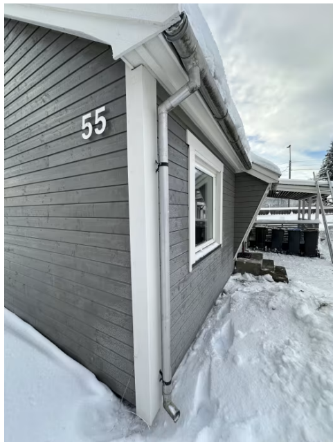
Viser takrenne og nedløpsrør med utkast.
