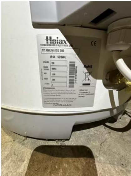
Viser teknisk data på bereder
