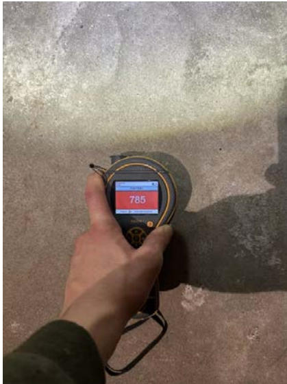
Viser fuktmåling mot kjellergulv.
