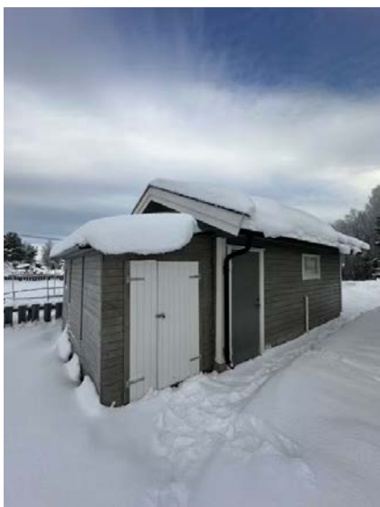
Viser inntilbygget bod i bakkant av garasje.
