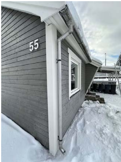
Viser takrenne og nedløpsrør med utkast.
