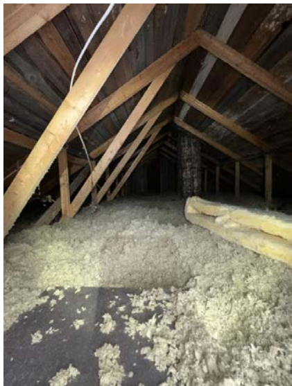
Viser kaldtloft med adkomst via luke i gavlvegg.
