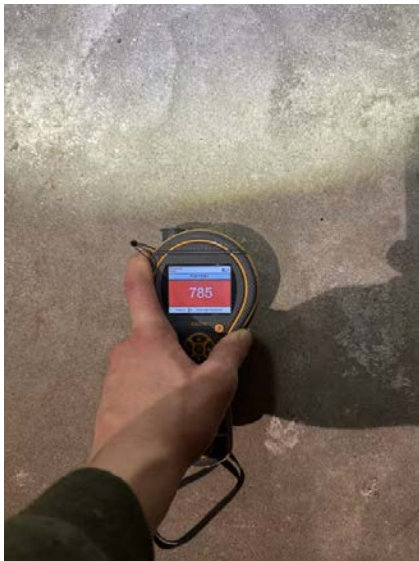
Viser fuktmåling mot kjellergulv.
