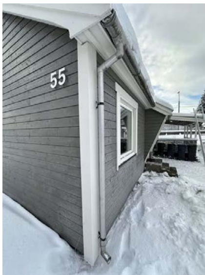
Viser takrenne og nedløpsrør med utkast.
