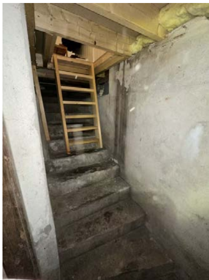
Viser trapp med adkomst til kjeller. Trappen tilfredsstillers ikke dagens krav til sikkerhet.
