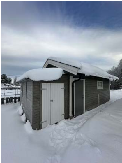
Viser inntilbygget bod i bakkant av garasje.
