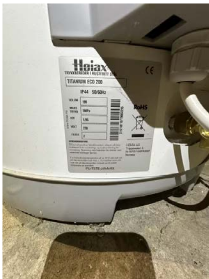
Viser teknisk data på bereder
