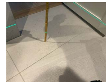
Slukrenne langs vegg.
