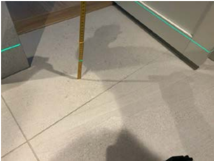
Slukrenne langs vegg.
