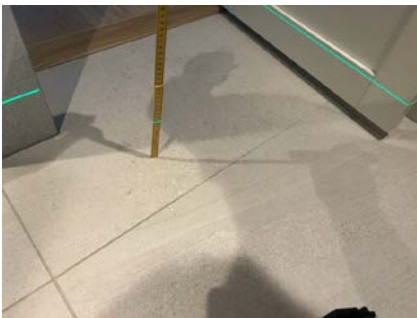
Slukrenne langs vegg.
