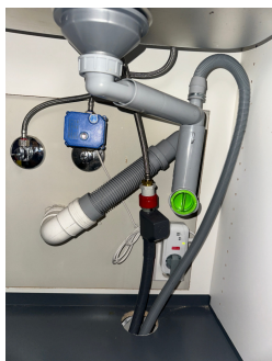
Rørapplegg i kjøkkenbenk med Waterguard
