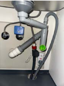
Røropplegg i kjøkkenbenk med Waterguard
