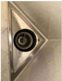
Stålsluk med klemring for membran
