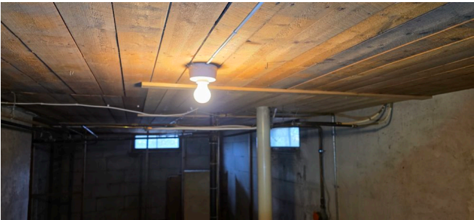
Bilde 1 Flere lamper i kjeller mangler kuppler.
