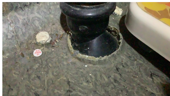
Utett vinylbelegg rundt gjennomføring.
