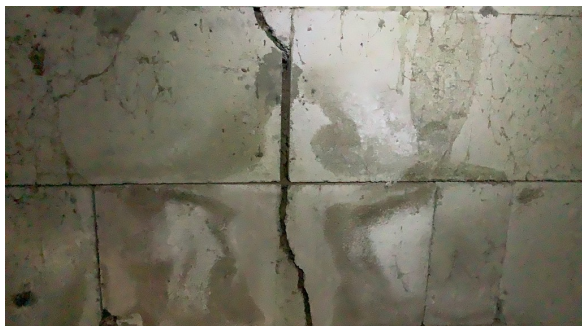
Innvendig sprekkdannelse.
