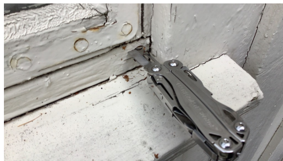
Råteskadet vindu.
