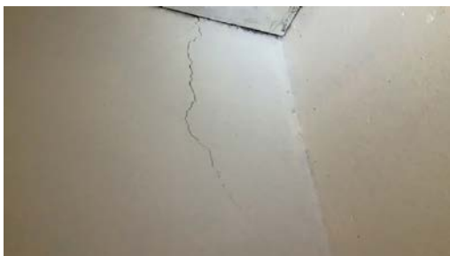
Riss i pipe.
