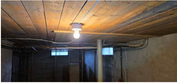
Bilde 1 Flere lamper i kjeller mangler kuppler.
