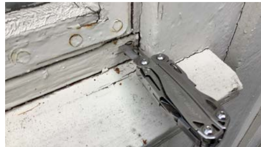
Råteskadet vindu.
