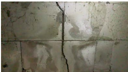
Innvendig sprekkdannelse.
