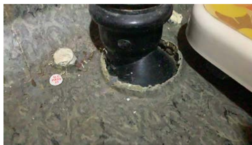
Utett vinylbelegg rundt gjennomføring.
