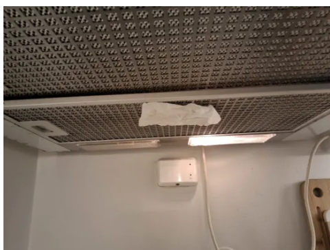
Avtrekkseffekt er testet med papir.
