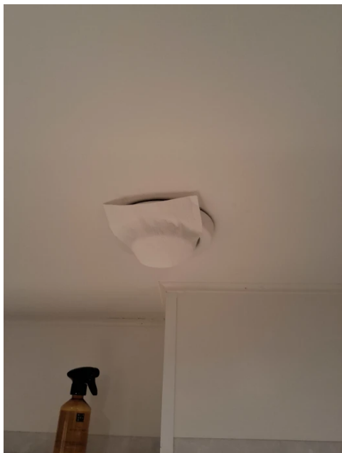
Avtrekkseffekt er testet med papir.
