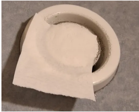
Avtrekkseffekten er testet med papir.
