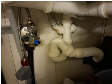
Leiligheten har synlige avløpsrør av plast.
